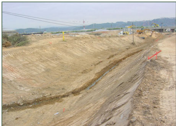
Terrassements en mai
