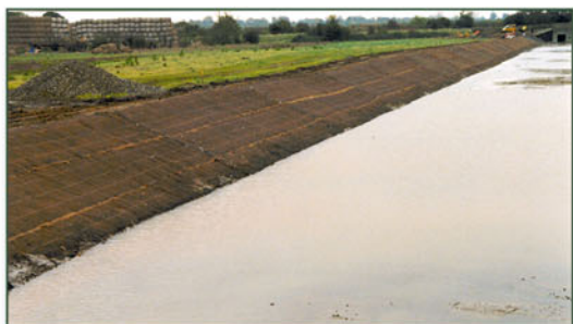
Chantier en avril
