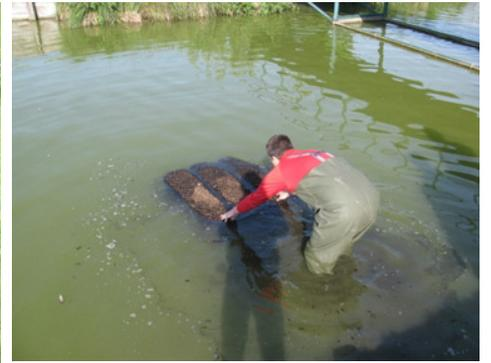
Les boudins, entouré d'un filet PE, ont une longueur de 90 cm et un diamètre de 20 cm. Le poids sec est d'environ 4 à 6 kg/ pièce.
