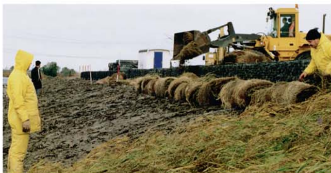
Octobre – Novembre 2001 : Installation des géonattes coco de phragmites
