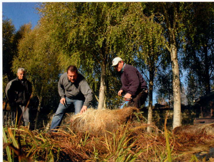
LE DÉROULEMENT DES NATTES PRÉVÉGÉTALISÉES s'effectue sans appareil de levage et équipements lourds.
