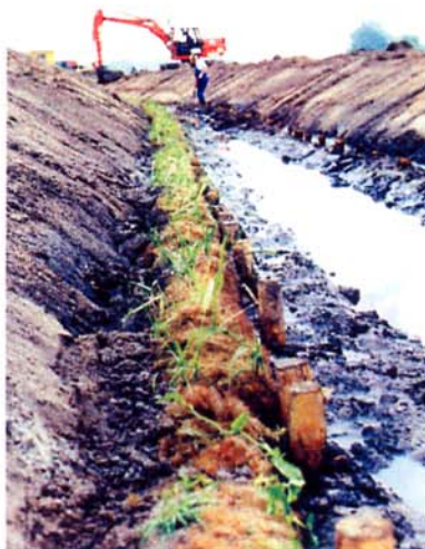
Contrôle de l'érosion. Installation des boudins Aqua-Flora® en mai
