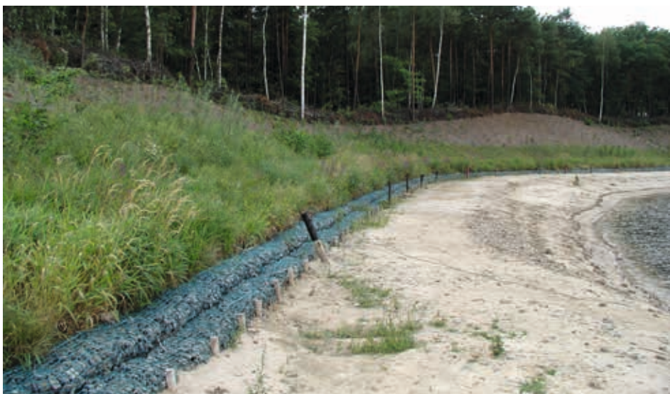
Quelques mois après la fin d'un chantier, la végétation reprend ses droits et les gabions maintiennent alors l'ensemble de façon très discrète.
