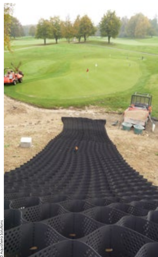
Déploiement du premier panneau alvéolaire, talus à 40°, golf.
